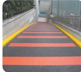
내리막 도로의 미끄럼 방지 포장
