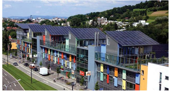
▲ 그림 94 _ 보봉 생태 주거 단지 지붕에 태양 전지판을 설치하여 전력을 생산하고, 나머지는 전력 회사에 판다.
