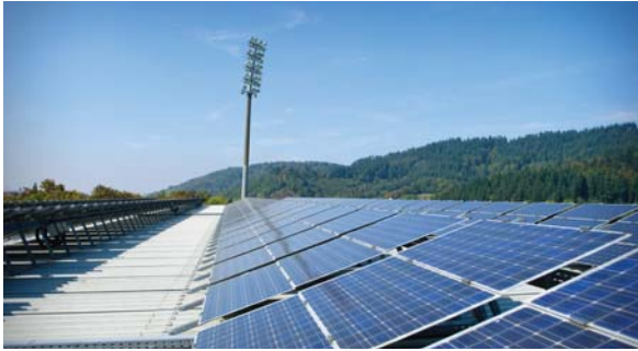
▲ 그림 93 _ 바데노바 축구 경기장 세계 최초의 에너지 자립 축구 경기장으로 지붕에 태양 전지판과 태양열 집열판을 설치하여 전기를 자체적으로 생산한다.
