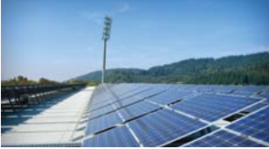
▲ 그림 93 _ 비테노바 축구 경기장 세계 최초의 에너지 자립 축구 경기장으로 지붕에 태양 전지판과 태양열 집열판을 설치하여 전기를 자체적으로 생산한다.
