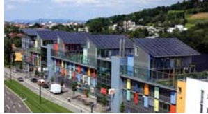
▲ 그림 94 _ 보봉 생태 주거 단지 지붕에 태양 전지판을 설치하여 전기를 생산하고, 나머지는 전력 회사에 판다.
