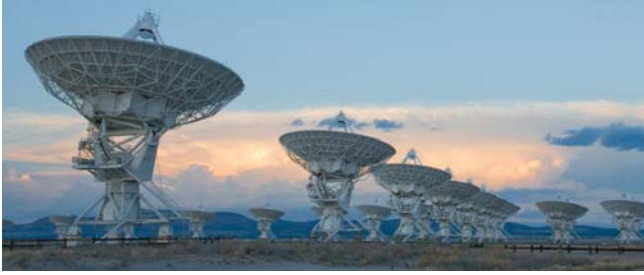
▲ 그림 34_ 미국 뉴멕시코 주의 VLA 지름이 25 m인 전파 망원경 27개가 Y자 모양으로 나열되어 지름이 130 m인 전파 망원경의 역할을 한다.
